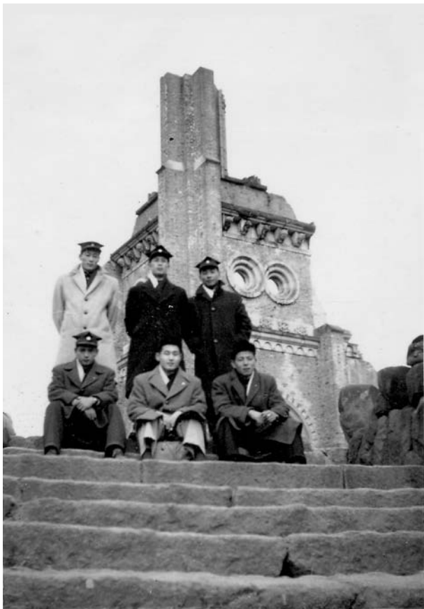
原爆によって破壊された浦上天主堂にて
